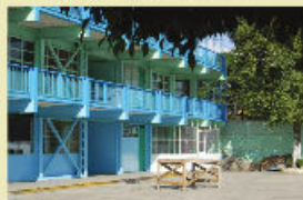
Mantenimiento de instalaciones por parte de los padres y maestros.
